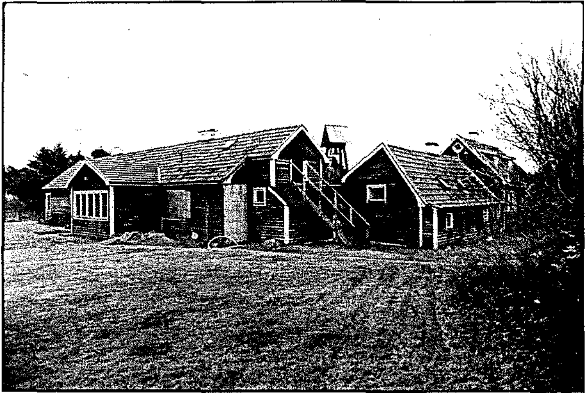
Färegården är en av de äldre gårdarna i Mellbystrand, men genomgick en omfattande renovering på 1940-50-talet.
