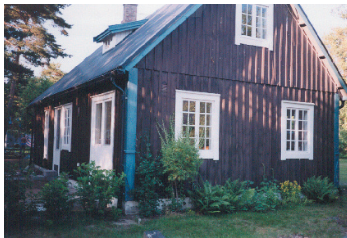
Fönster och dörrar tillverkades förr av utvalt kärnvirke. Kvaliten på dessa är ofta bättre än dagens nyproducerade dörrar och fönster.
