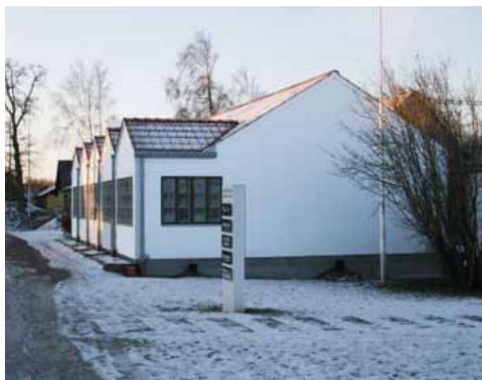
Lundströms bodar i Mellbystrand med pannor direkt på putsen
